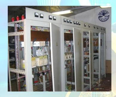
ГРЩ предназначен для приема и распределения электроэнергии трехфазного переменного тока напряжением 380/220 В. в сетях с глухозаземленной нейтралью, защиты групповых линий от перегрузок и токов короткого замыкания.
