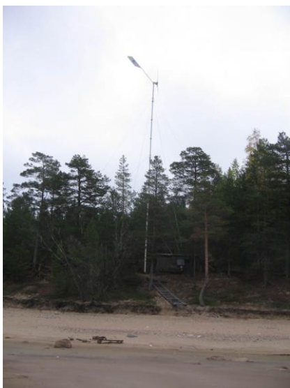
В Ветродизельный комплекс БРИЗ Дизель + 5 кВт Поселок Усть-Обжимка, Карелия
