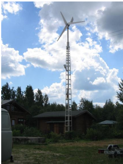
Ветроустановка БРИЗ Лидер 5 кВт Поселок Лаврово, Ленинградская область
